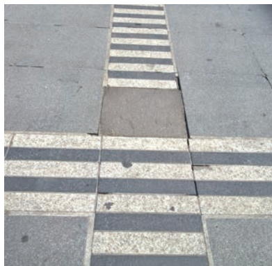
Barrettes lacunaires complétées par du bitume
