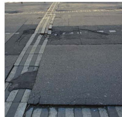
Affaissement de la chaussée
